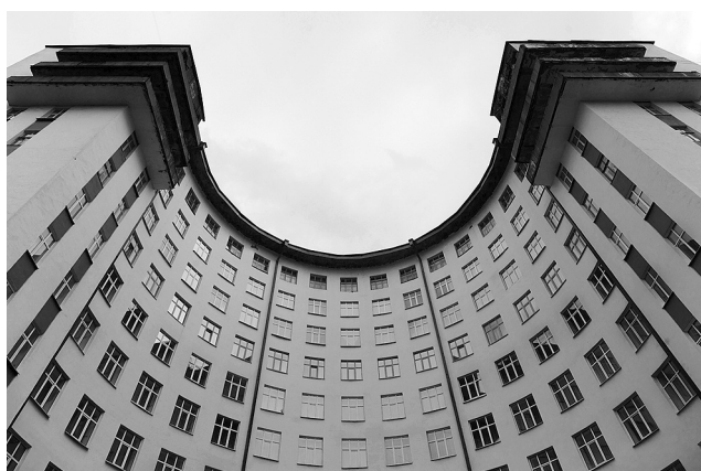
Ил. 6. Сергей Крылов. Внутренние фасадные решения гостиницы «Исеть». «Городок чекистов». Архитекторы И. Антонов, В. Соколов, А. Тумбасов, А. Стельмацук. Строительство 1929—1936 годов
